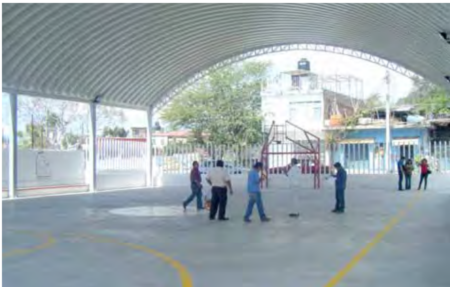
Supervisión a la obra cancha deportiva Carlota Ortiz, en el Municipio de Temixco, Morelos dentro del Programa Rescate de Espacios Públicos 2011.
