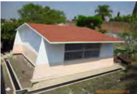
Jardín de Niños Silvia Palacios García de San Francisco Texcalpan, Jiutepec – Construcción de un aula didáctica más obra exterior, rehabilitación de instalación eléctrica, sanitarios e impermeabilización y construcción de drenaje de agua pluvial y alcantarillado.
