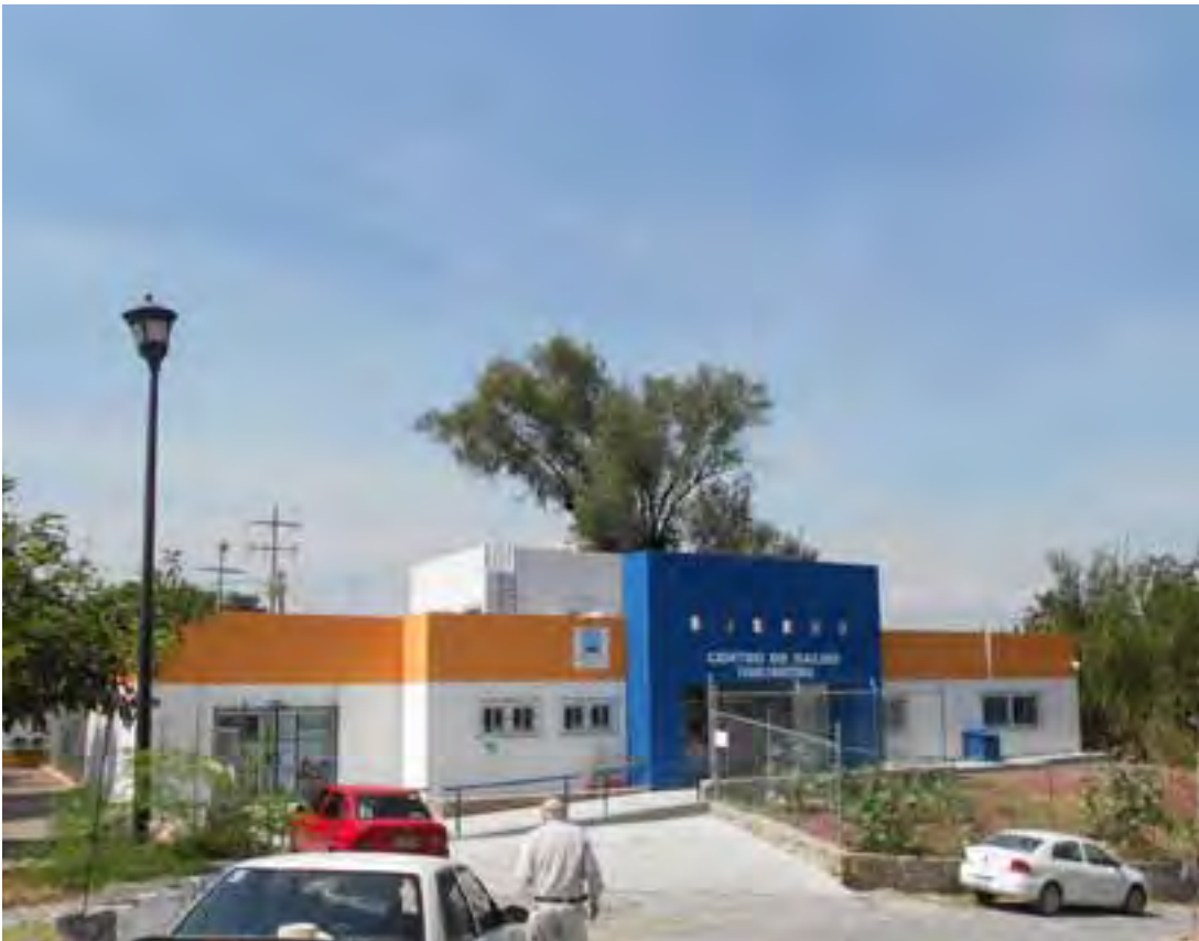
Sustitución por obra nueva del centro de salud de Tequesquitengo.
