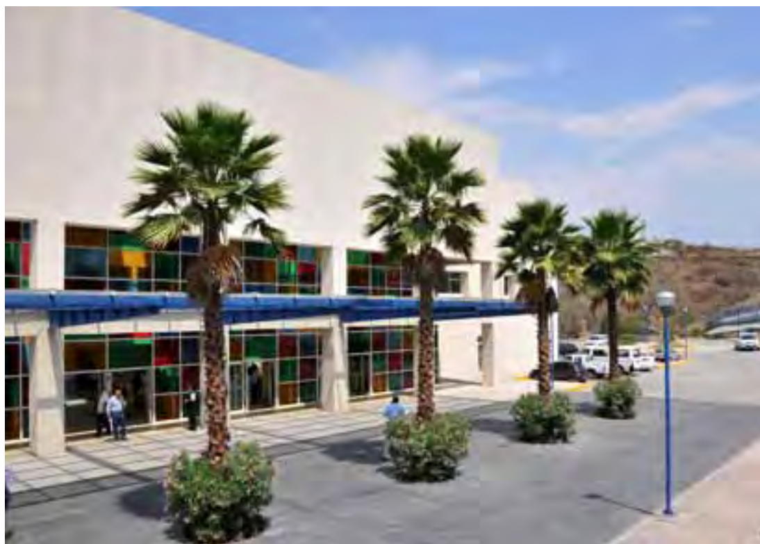
Con el Nuevo Hospital del Niño y el Adolescente, se brindará una mayor cobertura a este sector de la población.
