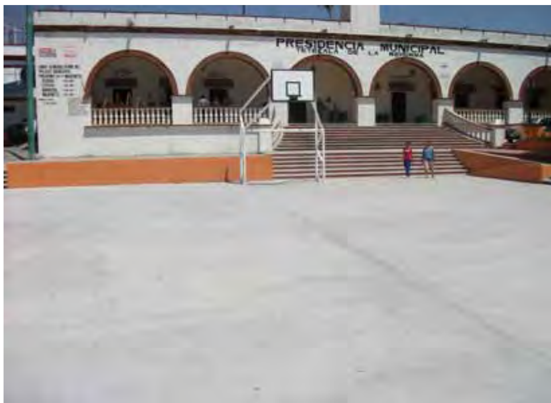
Rehabilitación de explanada de la cabecera municipal de Tetecala.
