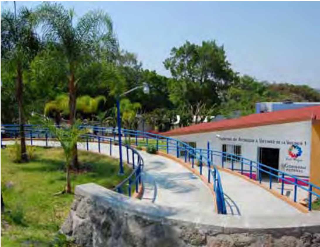
Rampa de acceso para personas con discapacidad del Centro Estatal de Desarrollo Integral Familiar (CEDIF) de Temixco.
