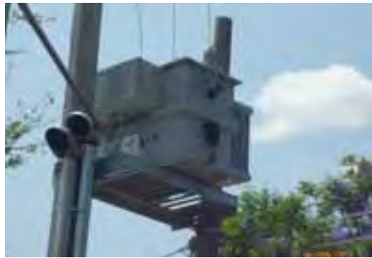
CBTA No. 39 Temoac – Suministro, colocación e instalación de transformador.
