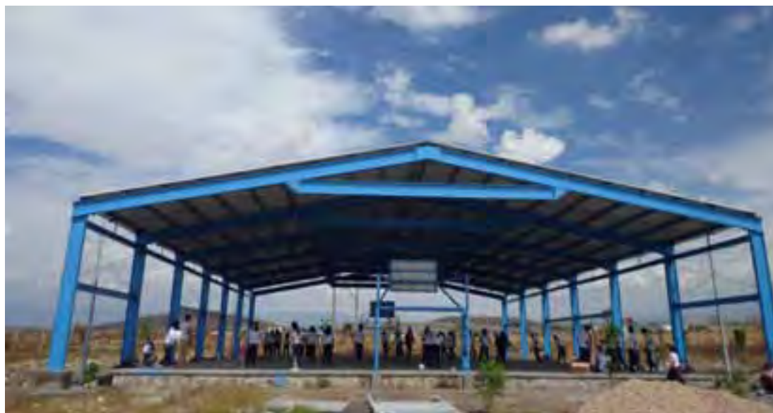
CECyTE No. 4, Tlayecac, Ayala – Construcción de techumbre metálica.
