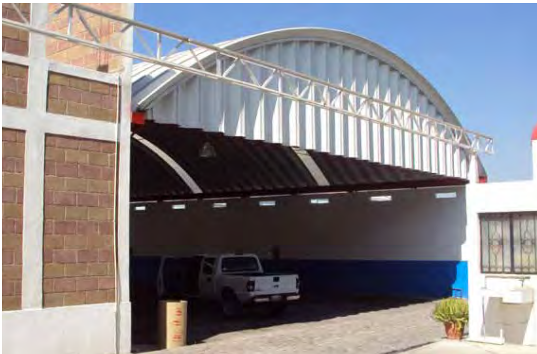
Verificentro en remodelación.
