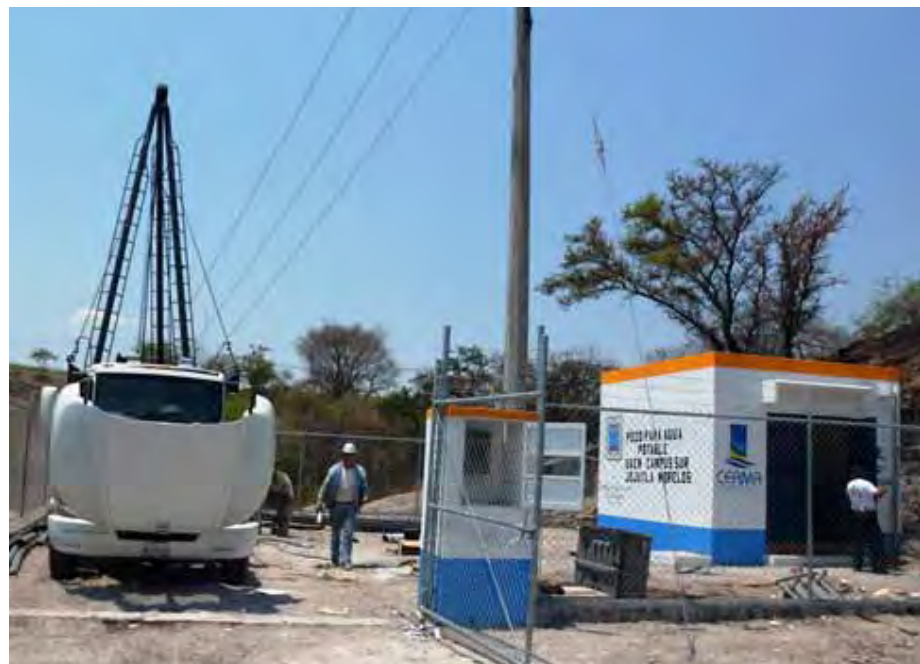
Perforación y equipamiento del pozo "El Jicarero" para dotar de agua potable al campus sur de la Universidad Autónoma del Estado de Morelos.
