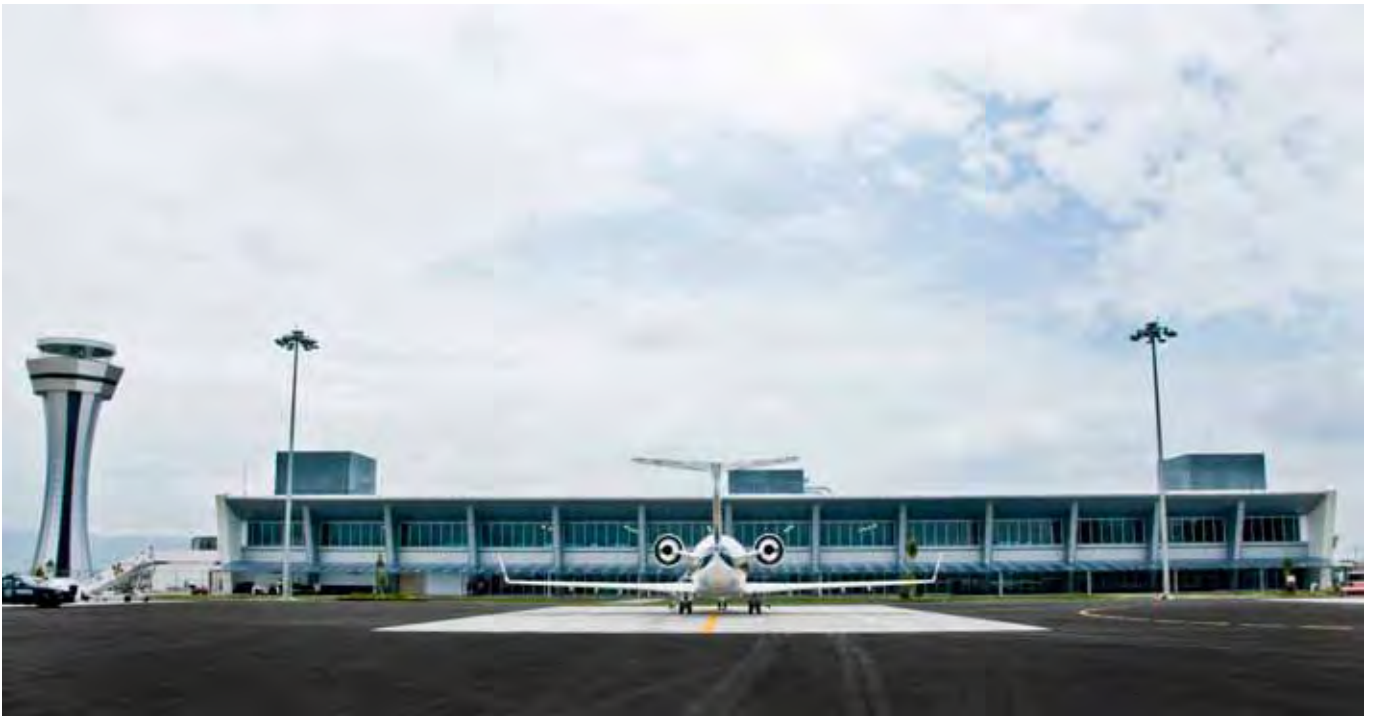
Nueva terminal aérea del Aeropuerto Internacional Mariano Matamoros.
