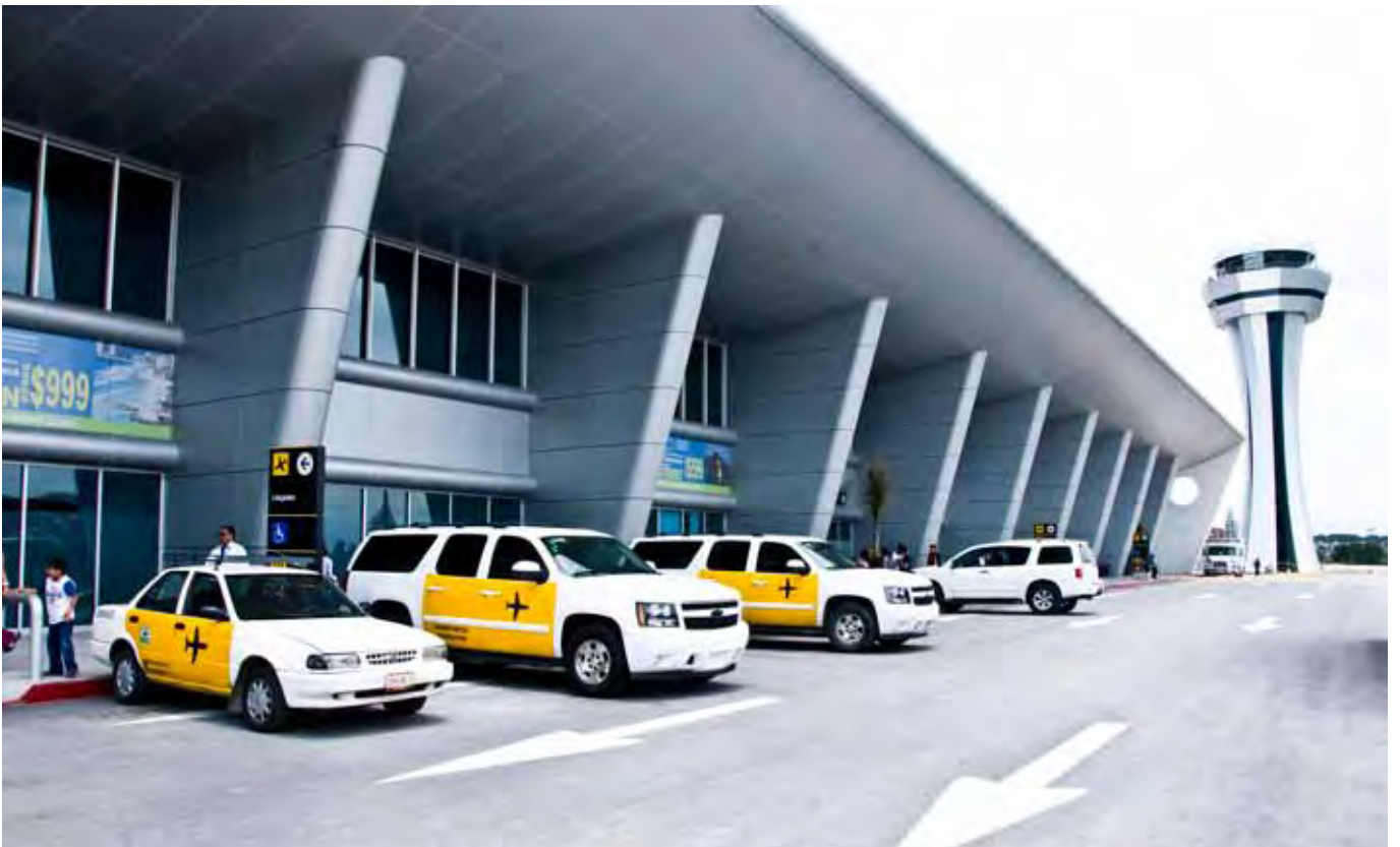
Instalaciones del Aeropuerto General Mariano Matamoros.
