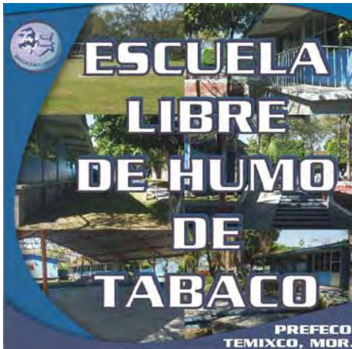
Escuela Preparatoria Federal por Cooperación (PREFECO), edificio libre de humo de tabaco.
