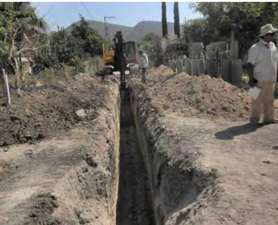
Construcción de alcantarillado sanitario, colonia Alfredo Bonfil en el Municipio de Tlaquiltenango.
