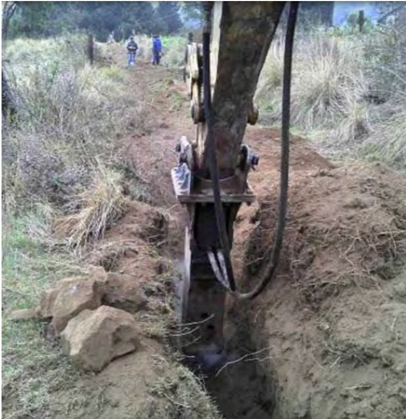
Construcción de red de agua potable colonia Los Olivos.
