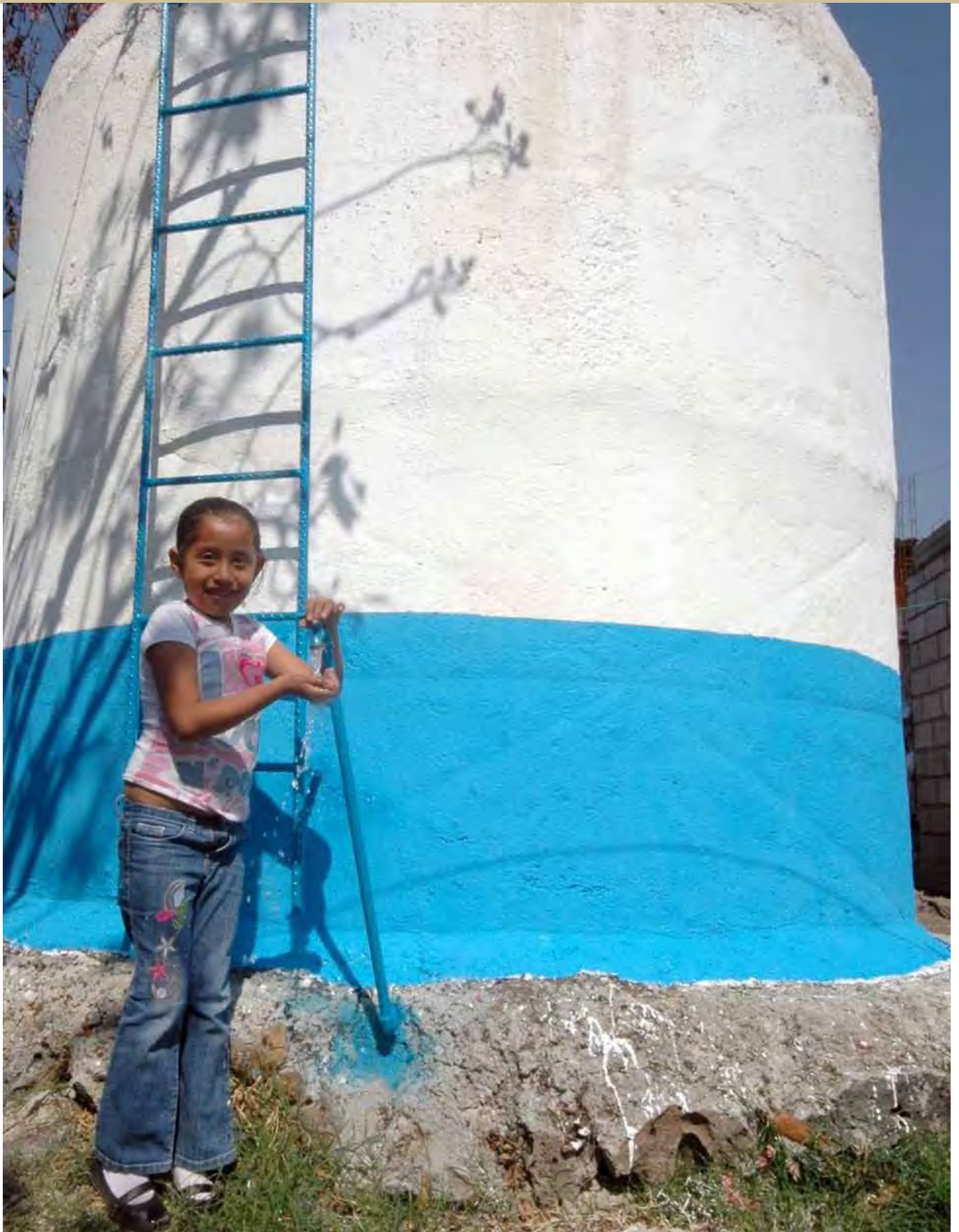
Construcción de cisternas domiciliarias.
