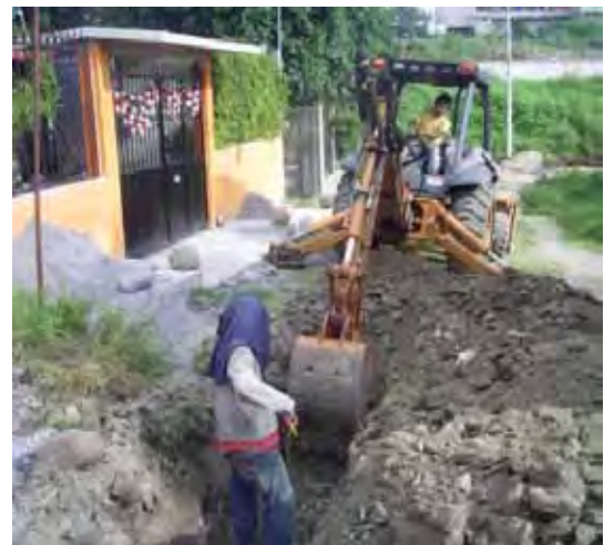
Construcción de red de distribución de agua potable, colonia Valle Dorado y Ampliación Tres de Mayo.
