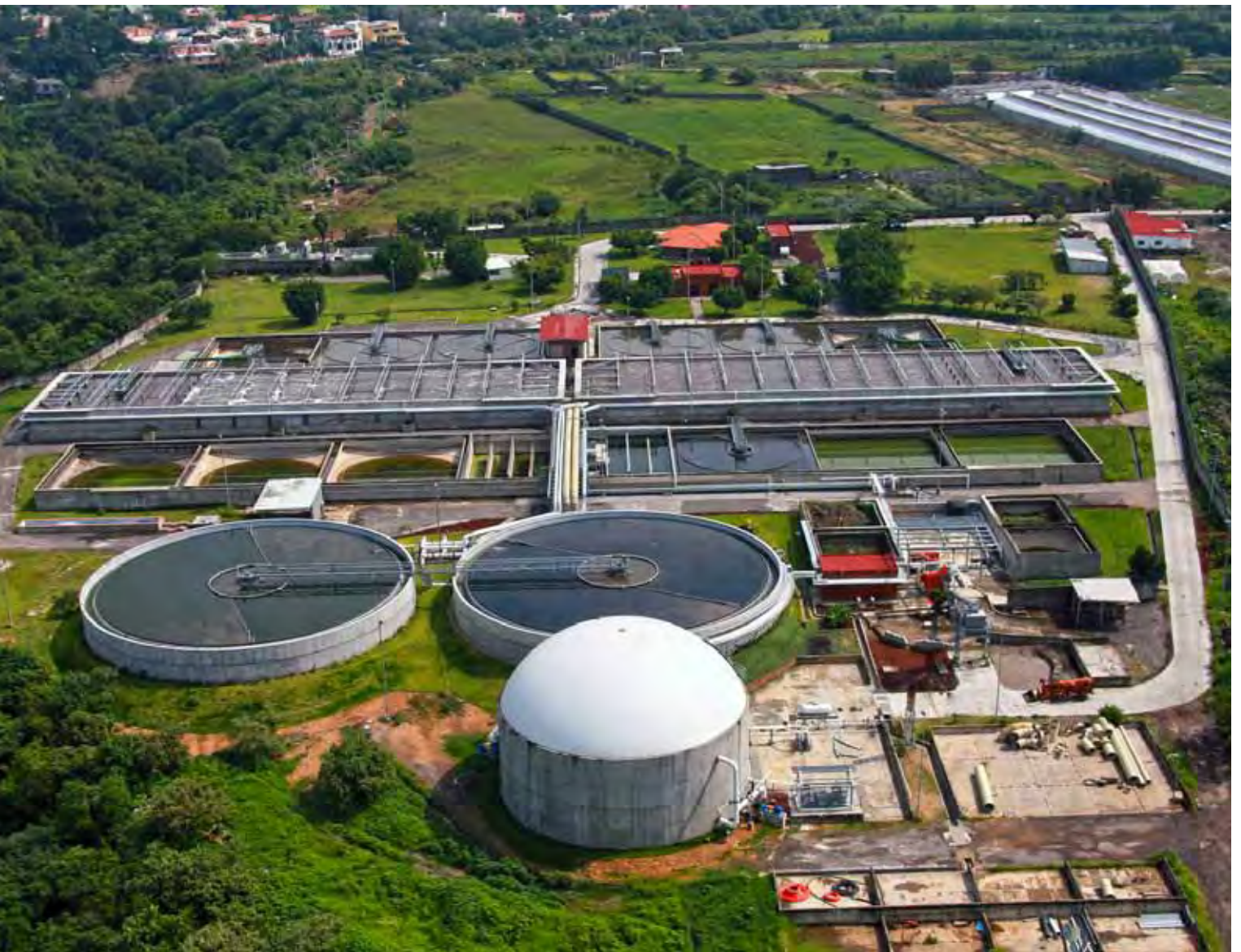
Planta de tratamiento de aguas residuales de Acapantzingo.
