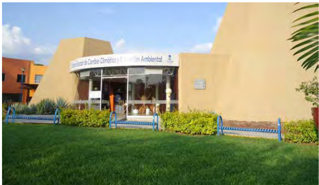
Vista externa del Centro de Cambio Climático.
